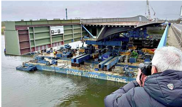
Hier fand der Vorschub des dritten Taktes mithilfe eines mitschwimmenden Pontons statt. FOTO: MARTIN FERCH
